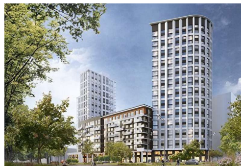
ЖК «Северное сияние»
